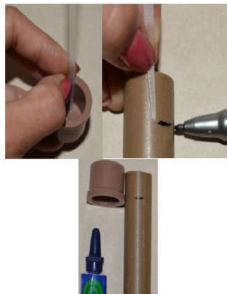
Fig. 11. Determinando a profundidade da conexão e marcando-a sobre a ponta do cano.
